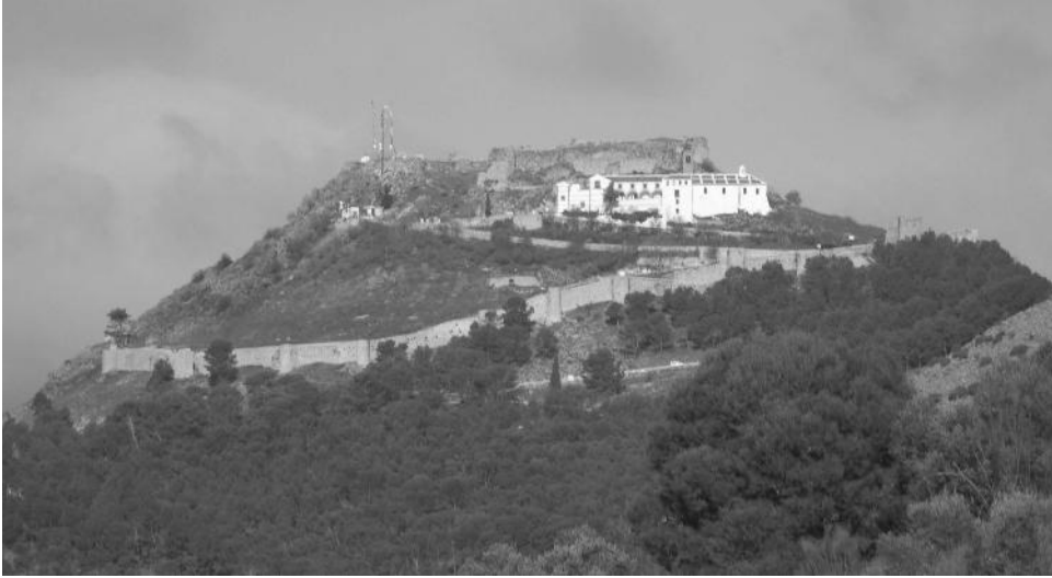
Figura 3. Vista general de la zona fortificada de la ciudad de Archidona.
